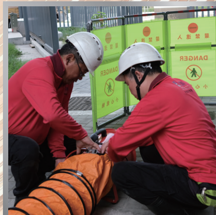
渠務處理及工程
